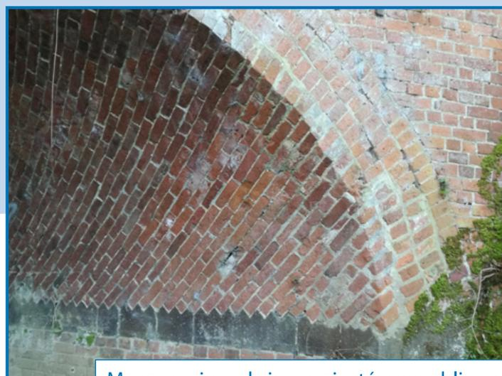
Maçonnerie en briques ajustées en oblique
